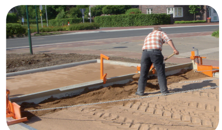
5,5 Meter werden passgenau zwischen Rinne und Bord abgezogen
