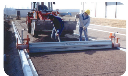
Höhenverstellbare Laufwerke im Einsatz über Bordsteinkante u. Niveau-Schienen
