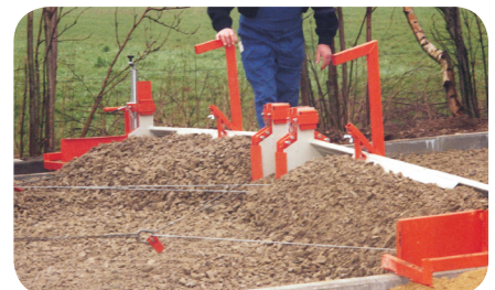
Schotter-Einbau bei einer Fahrstraße mit mittlerer Überhöhung (Dachprofil)
