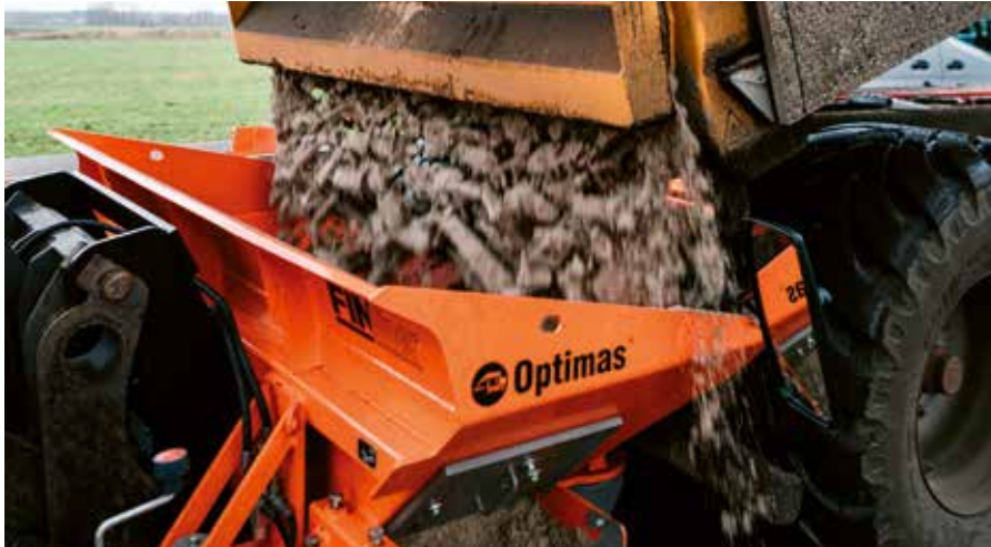
Die Schaufel wird direkt vom LKW befüllt
