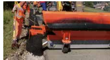
Asphaltbau (Schaufel 1,0 m³ mit hitzebeständigem Förderband und Abziehschild, Gummi)
