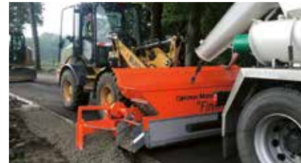
Bau von Randeinfassungen (Schaufel 1,0 m³ mit Materialrutsche, kurz und Abziehschild Stahl)
