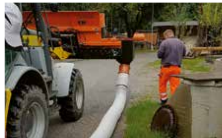
Hochwasserschutz: Befüllung von Sandschläuchen und Sandsäcken (Schaufel 1,0 m³ mit Einfülltrichter)
