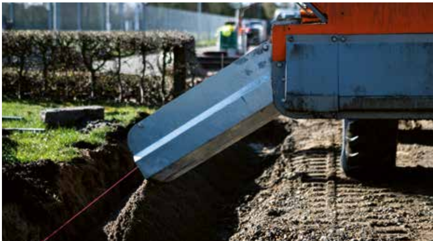
Bau von Randeinfassungen (Schaufel 1,0 m³ mit Materialrutsche, lang)
