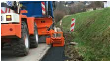
Materialverteilung: Abziehen mit Abziehschild Stahl (Schaufel 1,0 m³)
