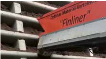
Befüllen Lärmschutzwand (Schaufel 1,0 m³ mit Materialrutsche, kurz)
