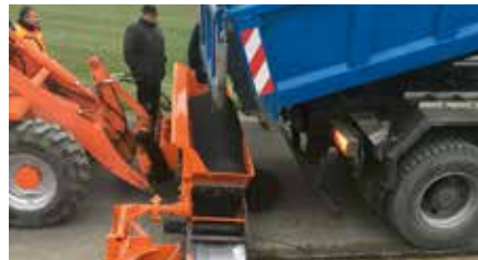
Die Schaufel wird direkt vom LKW befüllt
