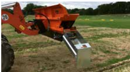
Drainagegräben mit Kiesel befüllen (Schaufel 1,0 m³)
